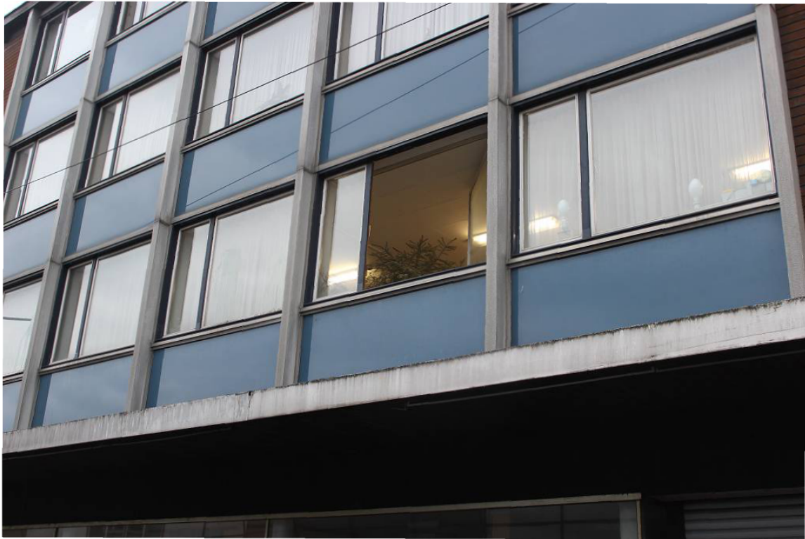
Vorbereitung des Wissener Fenstersturzes. Foto: Ingolf Wagner
