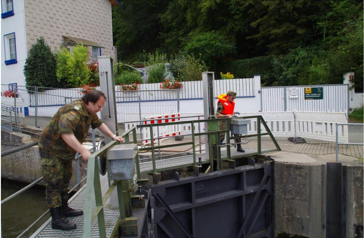
Zwei „Schleuser“ am Werk. Philipp Klevers (links) und Axel Wienand (rechts) beim manuellen Öffnen der Schütze am Zweiflügelstammtor der Schleuse Löhnberg.
