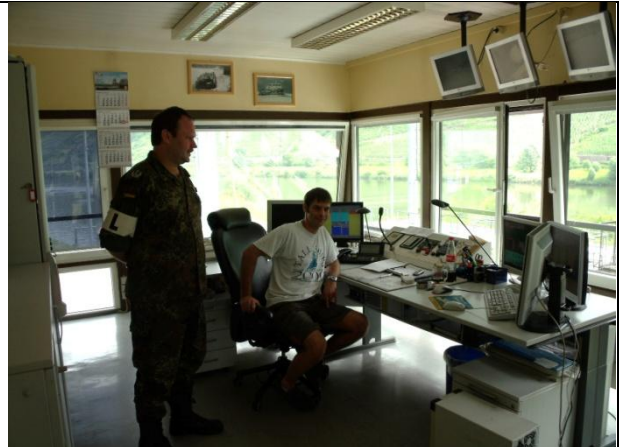
Axel Wienand (stehend) wird in Bedienung und Steuerung der Wehr – und Schleusenanlage vom Schleusenwärter eingewiesen. Foto: Peter Piechnitzek
