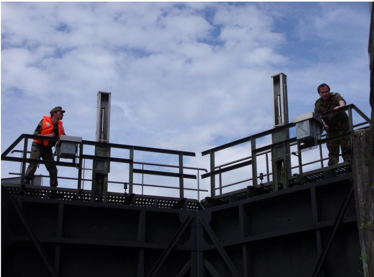
Zwei „Schleuser“ am Werk. Philipp Klevers (links) und Axel Wienand (rechts) beim manuellen Öffnen der Schütze am Zweiflügelstenttor der Schleuse Löhnberg.
