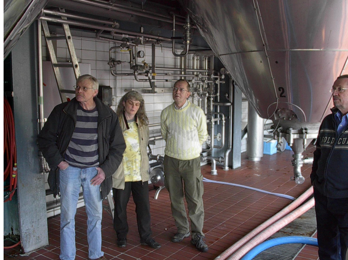
Gewaltig und zugleich faszinierend sind diese hohen Gärtanks. Foto: Axel Wienand
