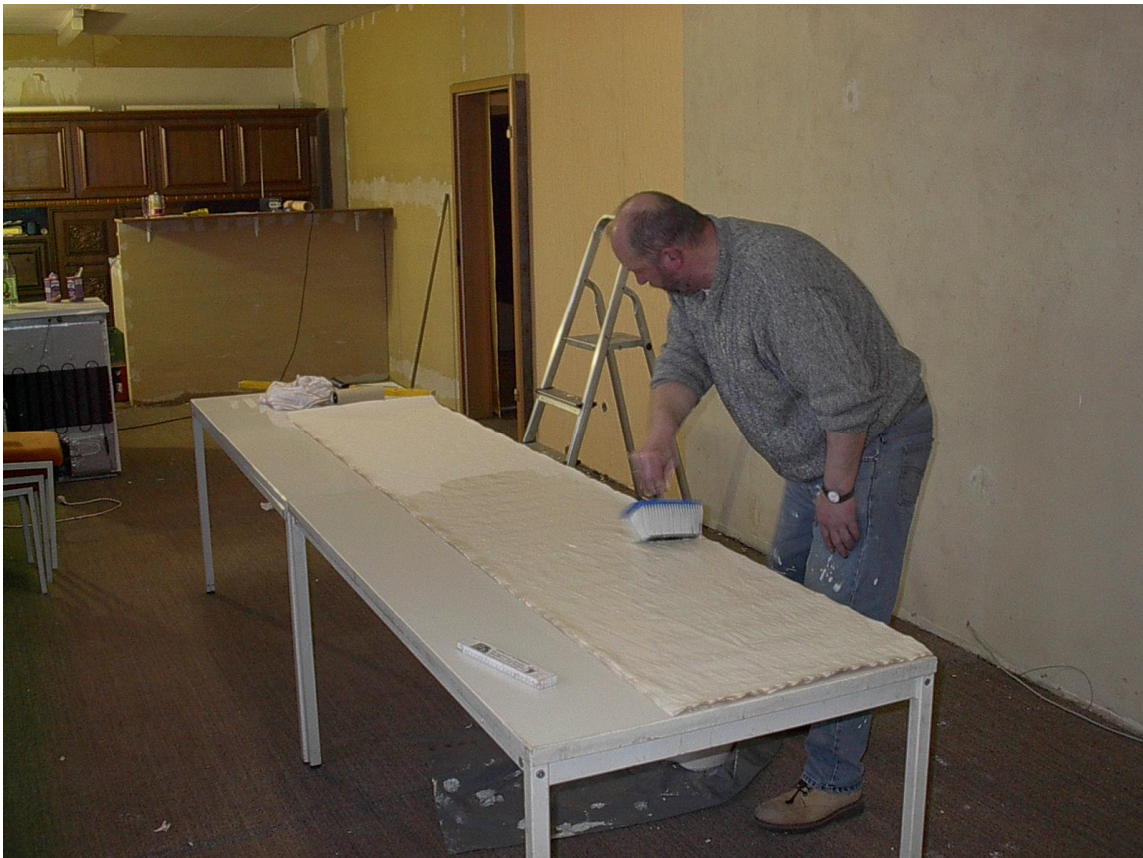
Michael Schneider beim Auftragen des Kleisters auf die Tapetenbahn. Foto : Axel Wienand
