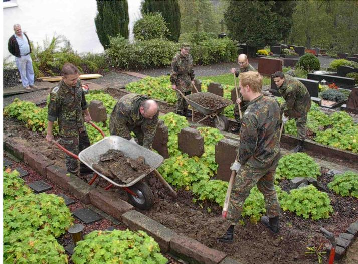
Erste Sanierungsmaßnahmen waren das Entfernen der maroden Sandsteinplatten, Randeinfassungen und die Beseitigung des Untergrundes.
